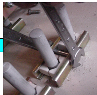
(4) 卸下固定瓷夹螺丝
